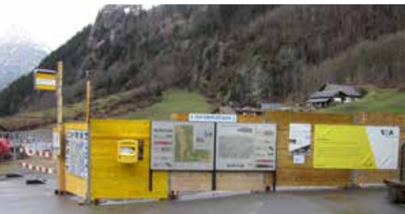
Provisorische Umgestaltung der Postautohaltestelle im Bereich der Talstation Luftseilbahn Golzern aufgrund der Bauarbeiten.
