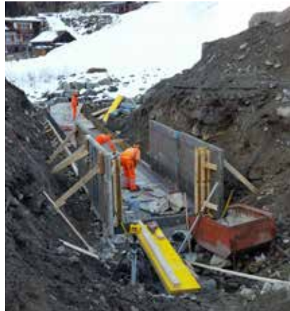
Bauarbeiten beim Unterwasserkanal in den Chärstelenbach.
