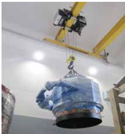
Die Maschinengruppe 2 wird mit Hilfe des Hallenkrans in die Aussparung eingepasst.
