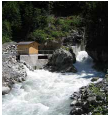
Wasserfassung Lägni in Betrieb
